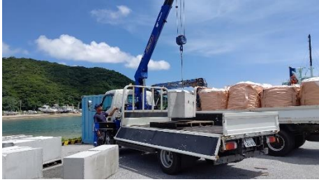
本島から基礎ブロックを運搬
