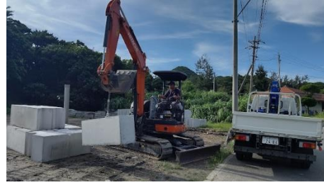
基礎ブロックを掘削整地して設置作業
