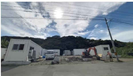
次に各部屋になるコンテナを設置する
